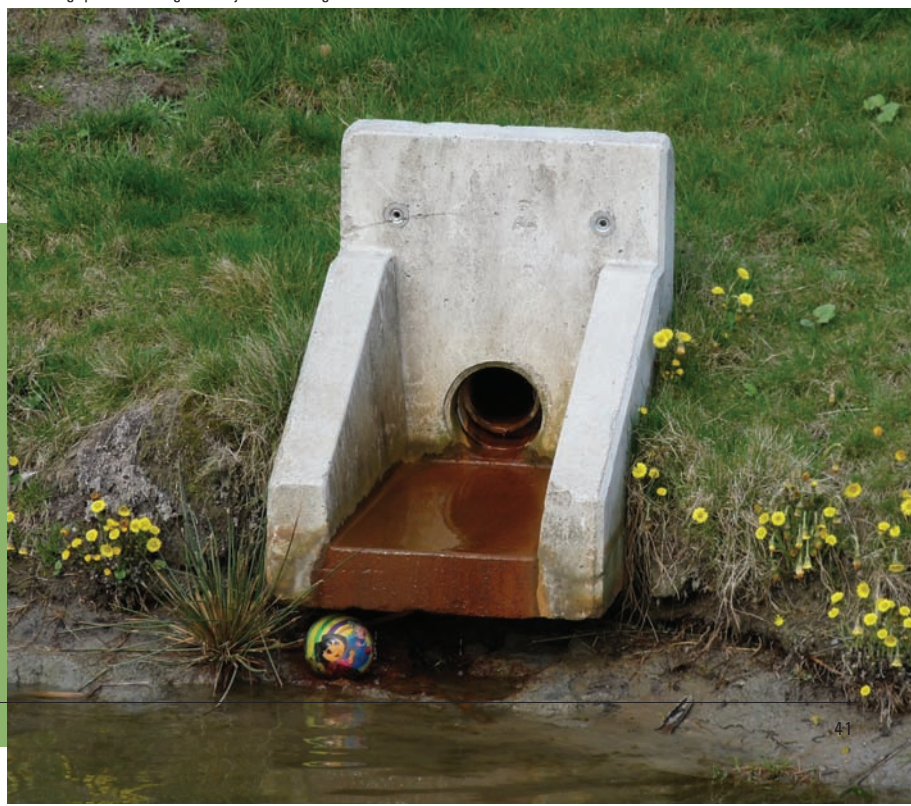
■ Lozingspunt drainage met ijzerafzetting.
