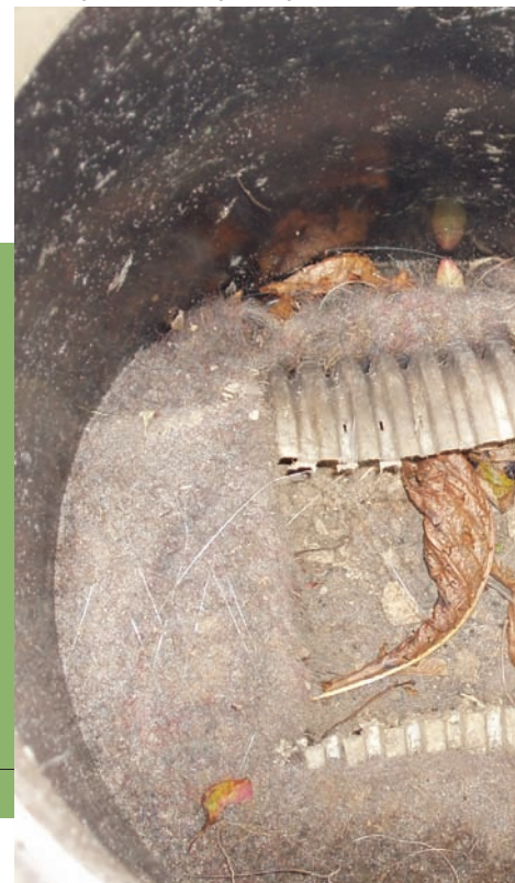
■ Dichtgeslibste drainageleiding.
