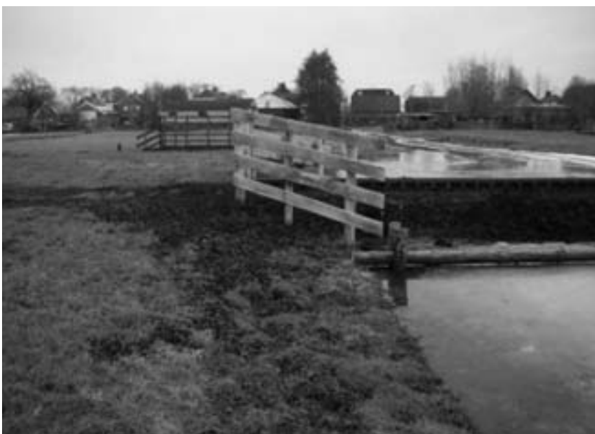
Foto 2. Een mogelijke maatregel om schade aan gebouwen door peilverlaging te voorkomen, is de aanleg van een hoogwatervoorziening, een watergang direct om de woning met een hoger streefpeil.
