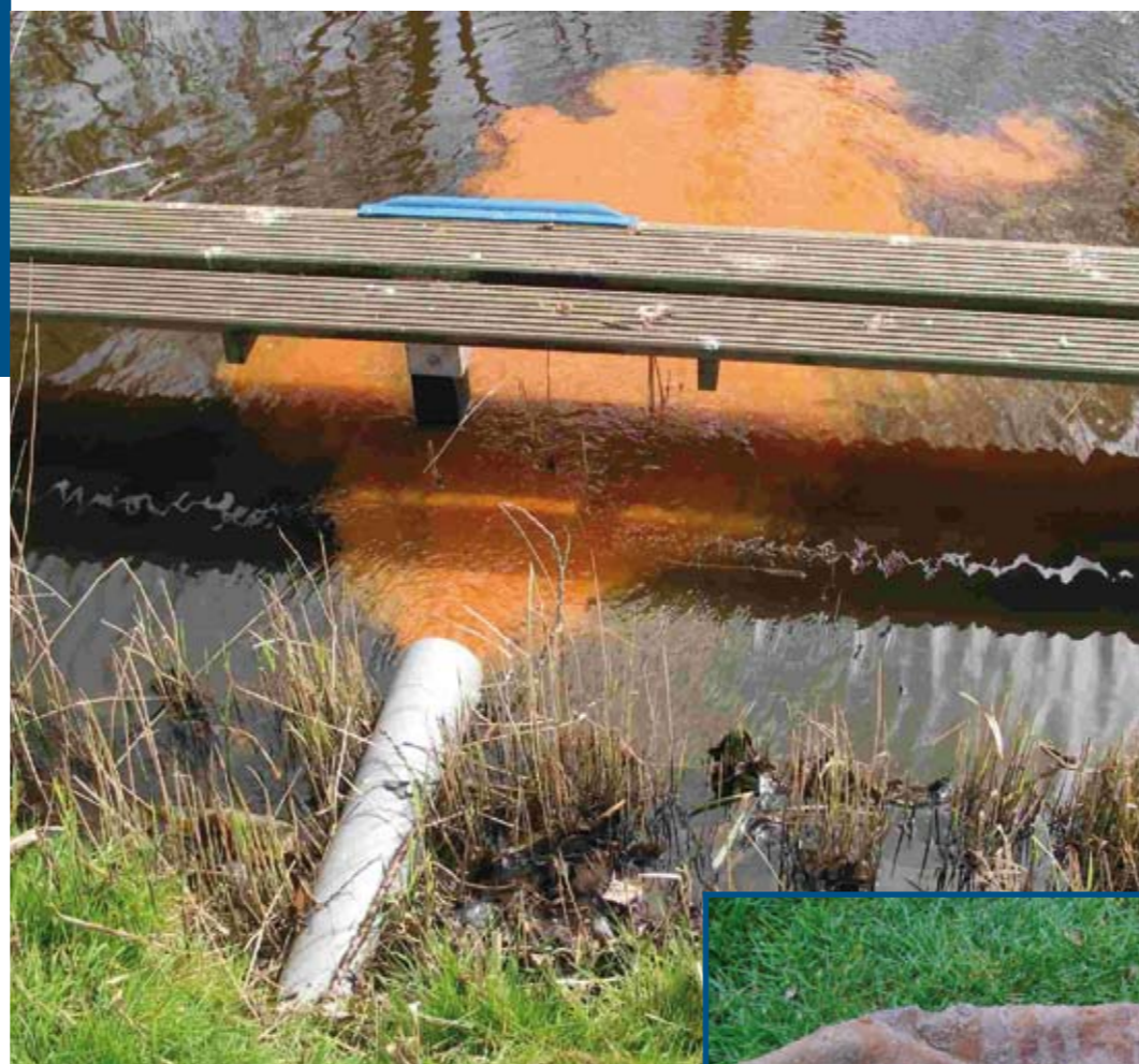
Afvoer ijzerrijk grondwater dat vrijkomt bij het doorspuiten.
