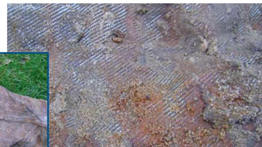
Ijzerafzettingen bij uitstroom drainage in put regenwaterriool.
