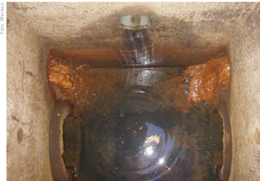
Ijzerafzettingen bij uitstroom drainage in put regenwaterriool.
