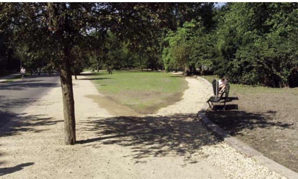
De wadi: regenwater zakt hier de bodem in naar de ondergrondse bodempassage.
