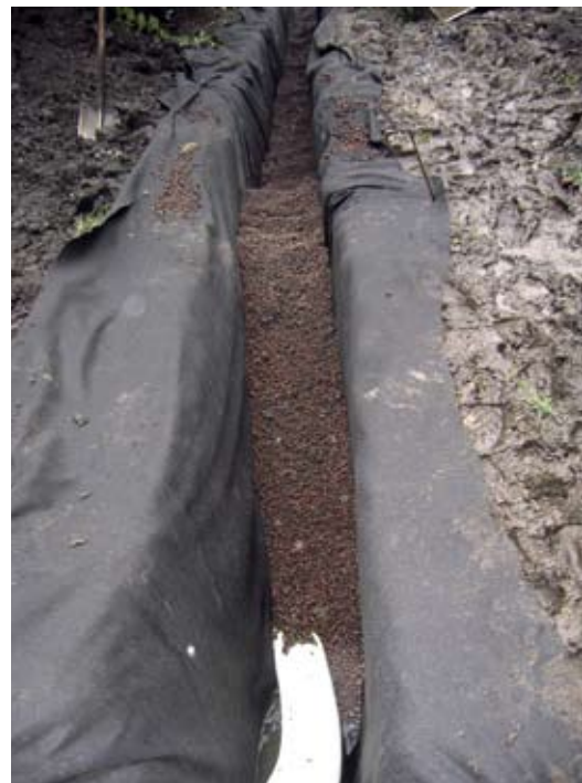
Aanbrengen van de lava voor de bodempassage voor het afvangen van verontreinigingen uit het water, en aanleg van de drain.
