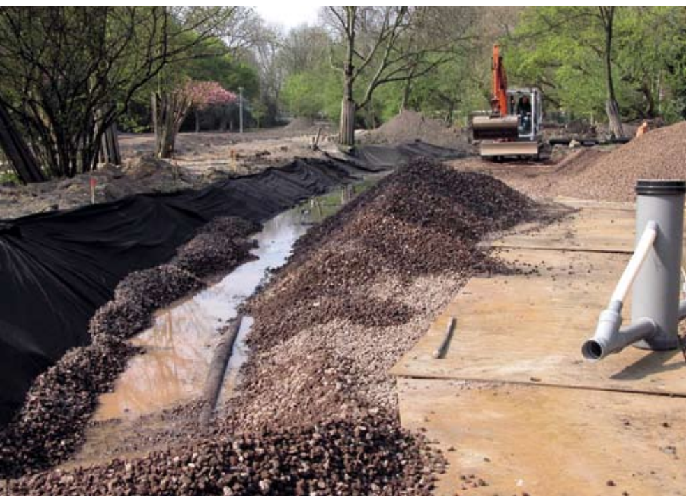
De wadi: regenwater zakt hier de bodem in naar de ondergrondse bodempassage.
