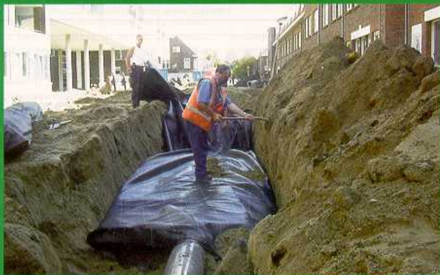
Tegelijk met de vervanging van de riolering is het infiltratiesysteem in de Wijkpolder aangelegd tussen februari en november 2000. geotextiel.
