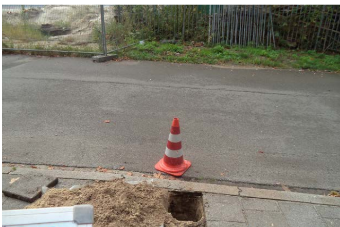
AFBEELDING 4: ASBESTGAT (FOTO: G. GISKUS, SIALTECH).
