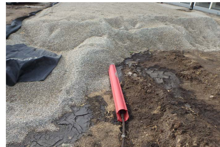
Aanleg van het bergingspakket.
