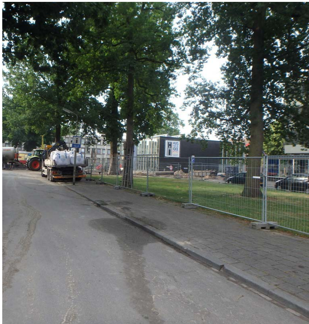
Aanleg van het duurzame waterbergingssysteem.
